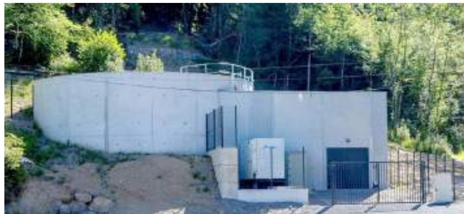
La station de pompage créée au Péage permet d'acheminer l'eau jusqu'au réservoir de Jarrigoux.
