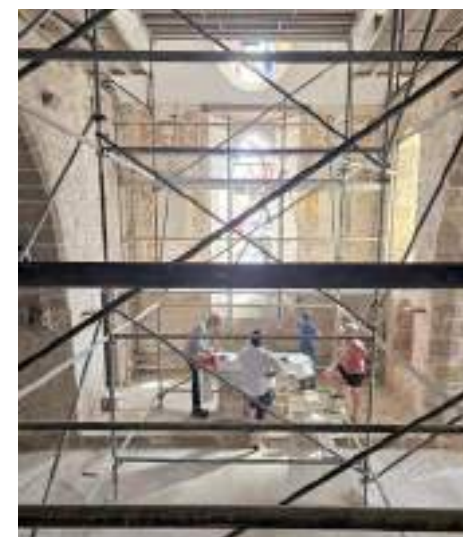
Cette 3 e tranche de travaux doit être achevée dans la première quinzaine de juillet.
