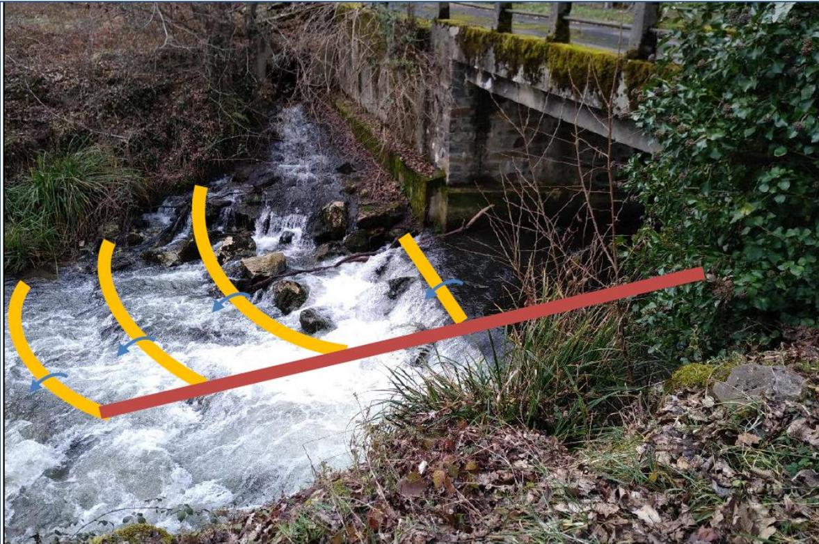
Figure 29 : Implantation des pré-barrages
